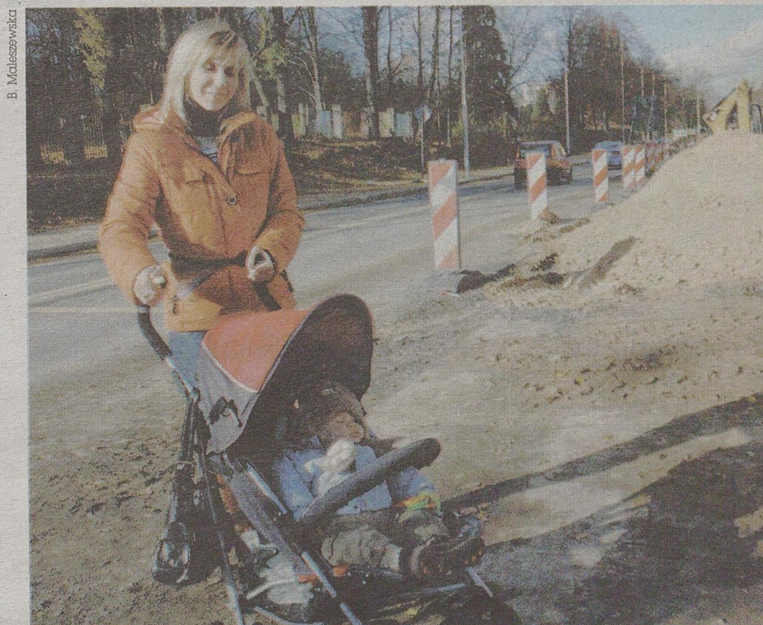
– Remont jest nieprzemyślany – uważa Beata Zimnoch, która przechodziła przez skrzyżowanie wraz z synkiem Kacprem
